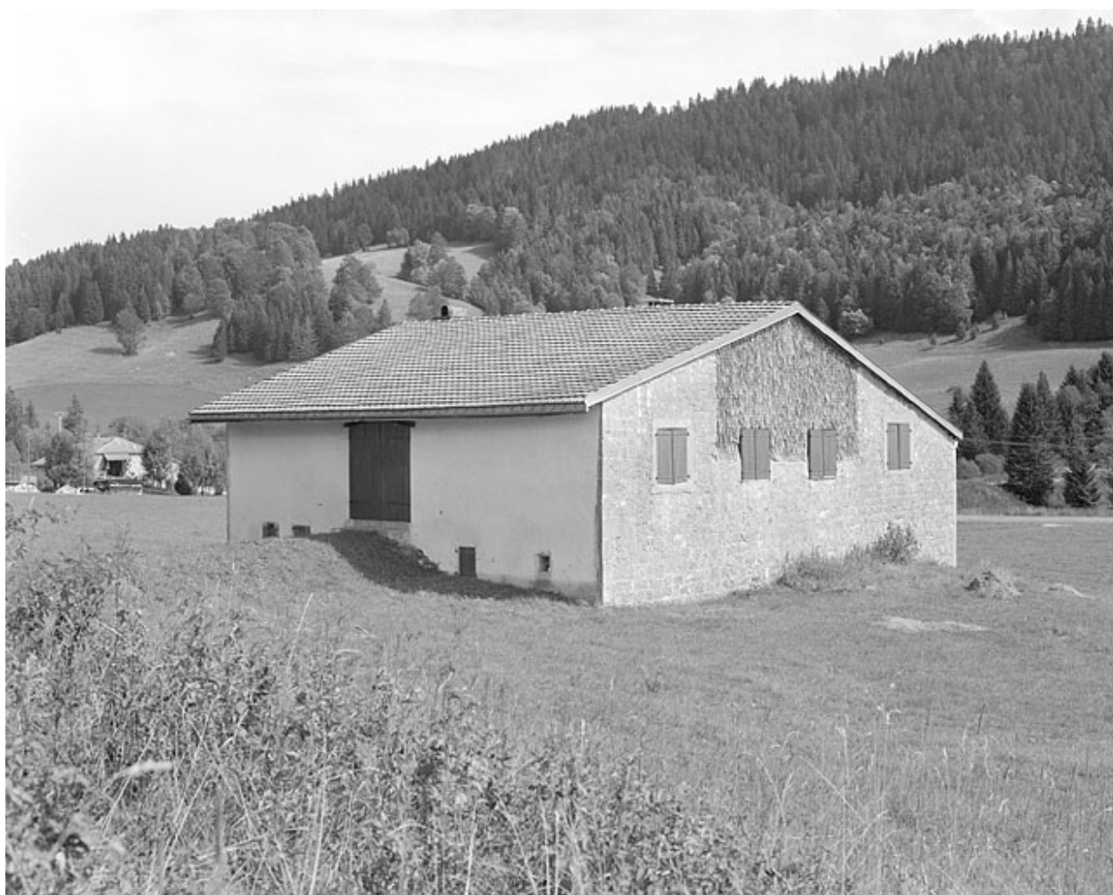
Façade postérieure et face sud-ouest.
