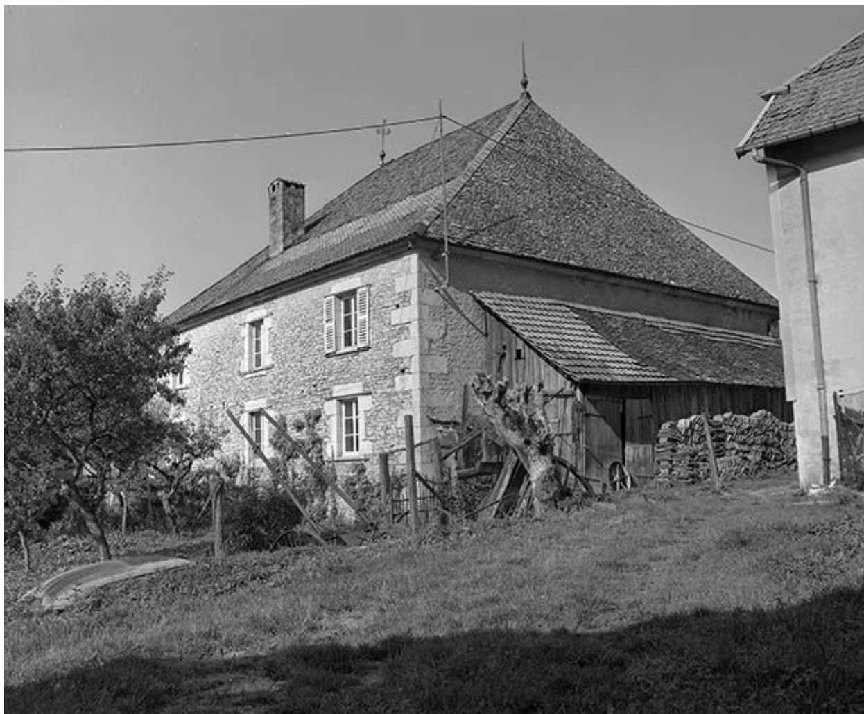
Façade postérieure vue de trois quarts droit.
