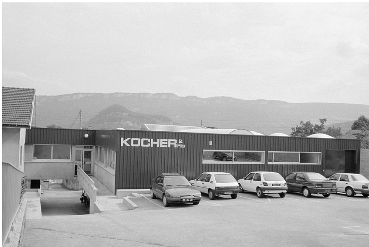
Atelier de fabrication et bureau (D).
