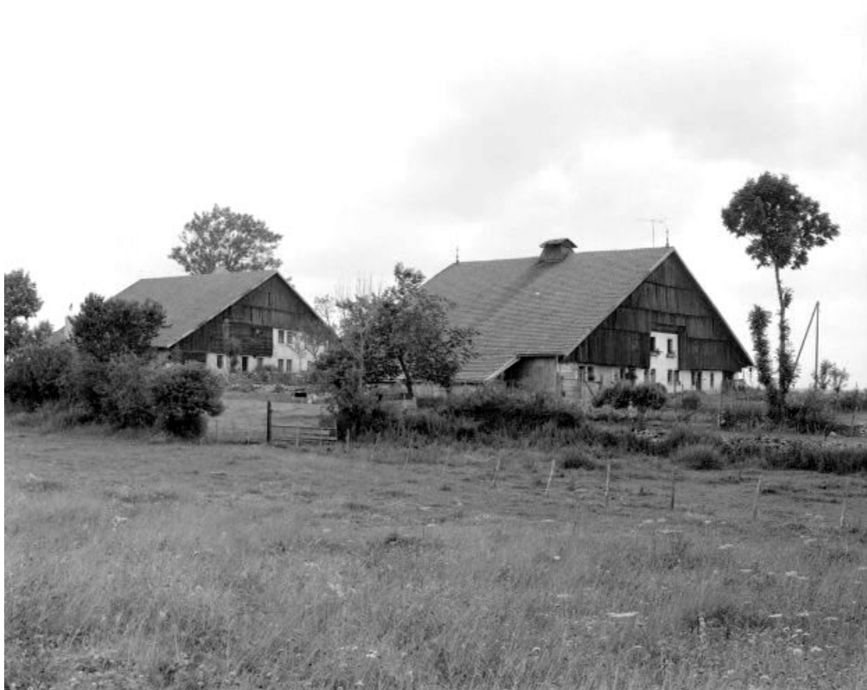
Les Combes : ferme située au lieu-dit La Motte
