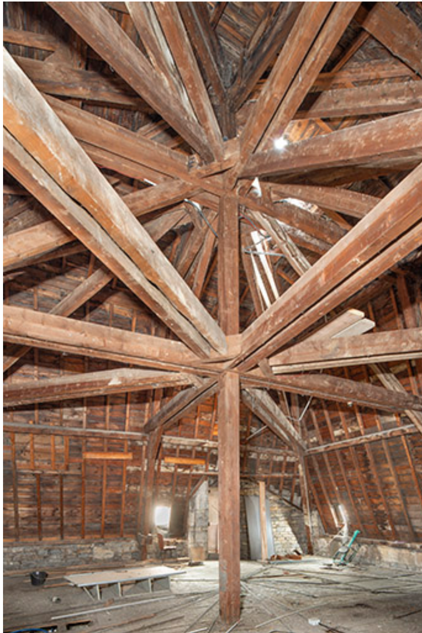
Charpente du pavillon ouest.
