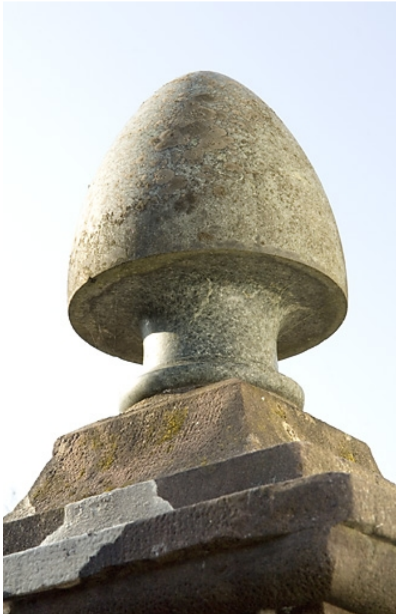
Elément décoratif en granit coiffant un des piliers de l'entrée.
