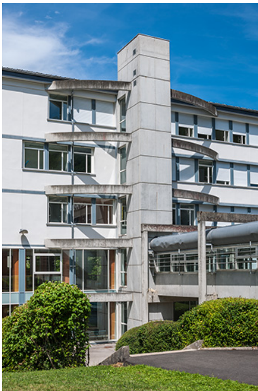
Internat : détail de la façade antérieure.
