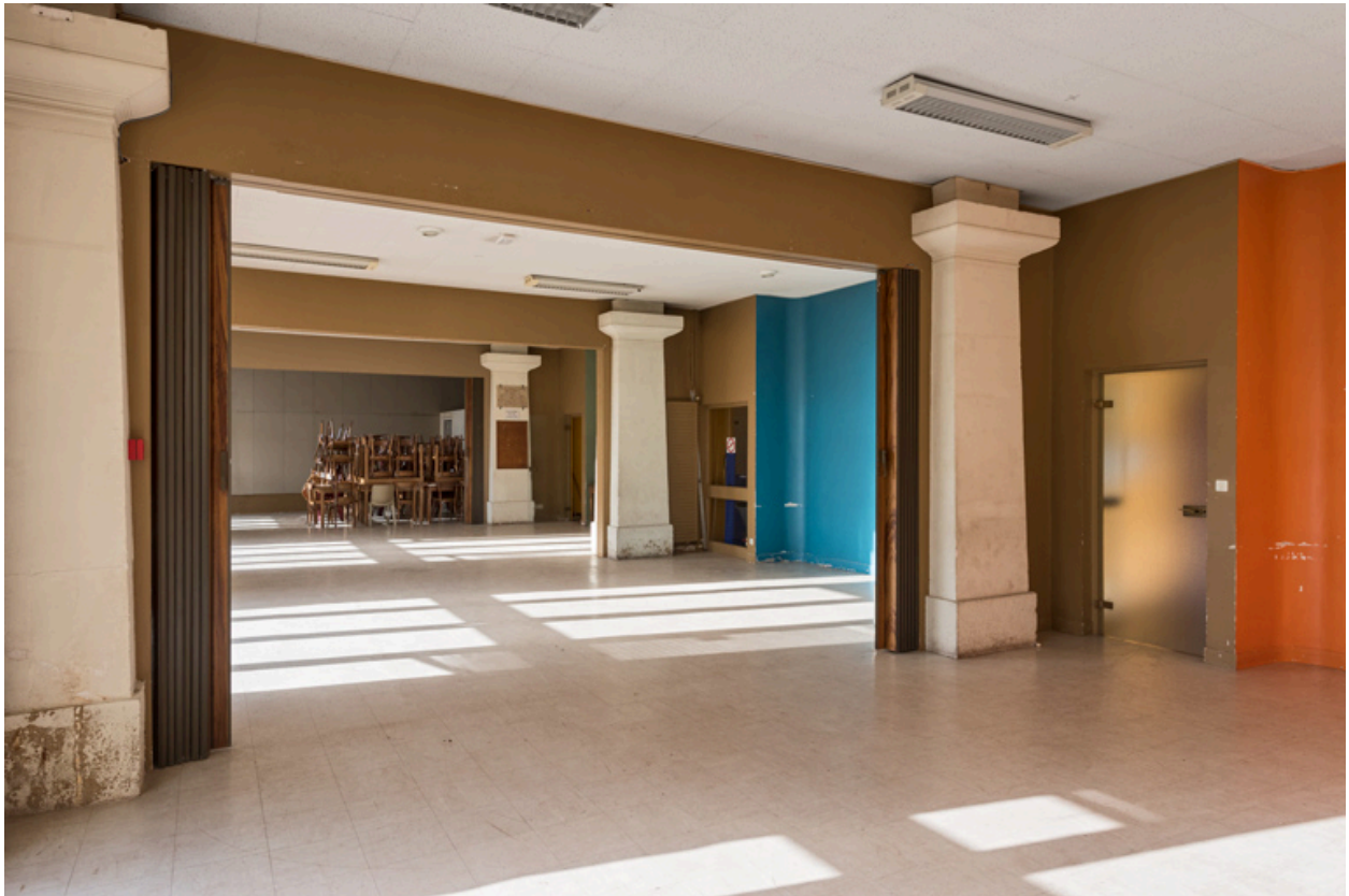
Ancienne halle au blé : alignement de piliers.
