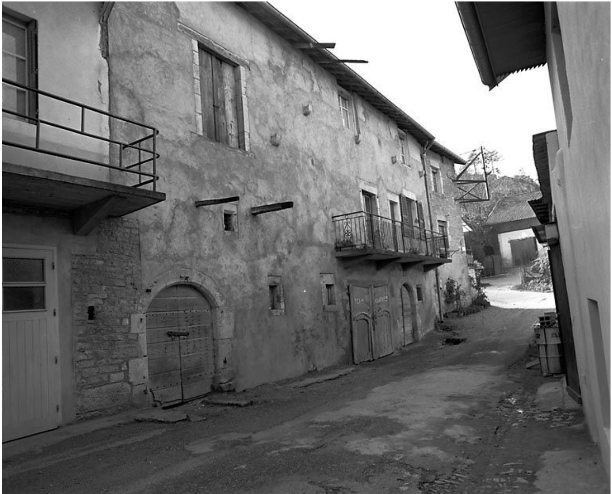
Maison située 1 chemin des Sablières.
