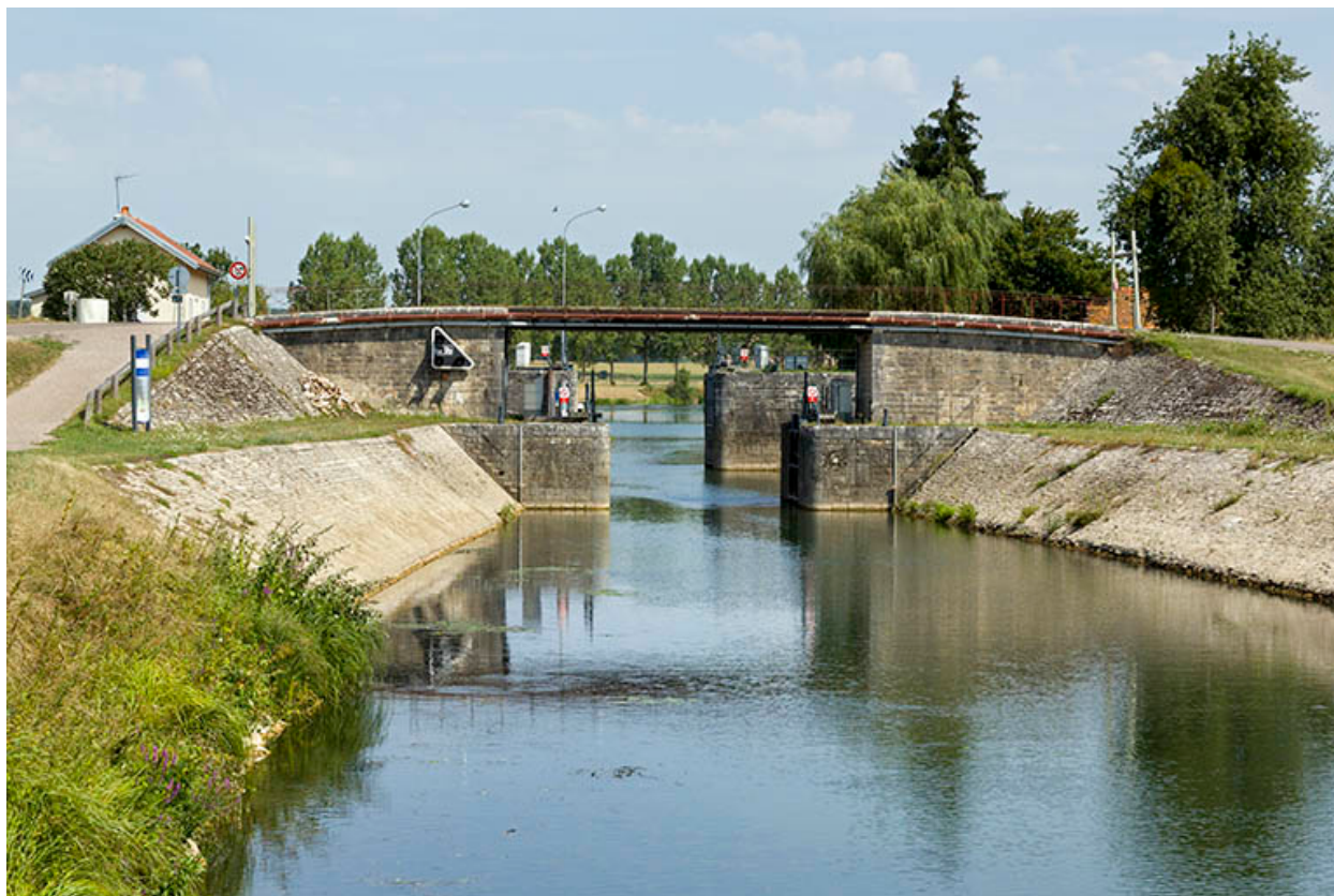
Entrée aval de l'écluse.
