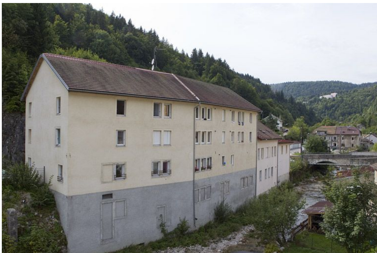
Façade sur la Bienne depuis l'est (amont).
