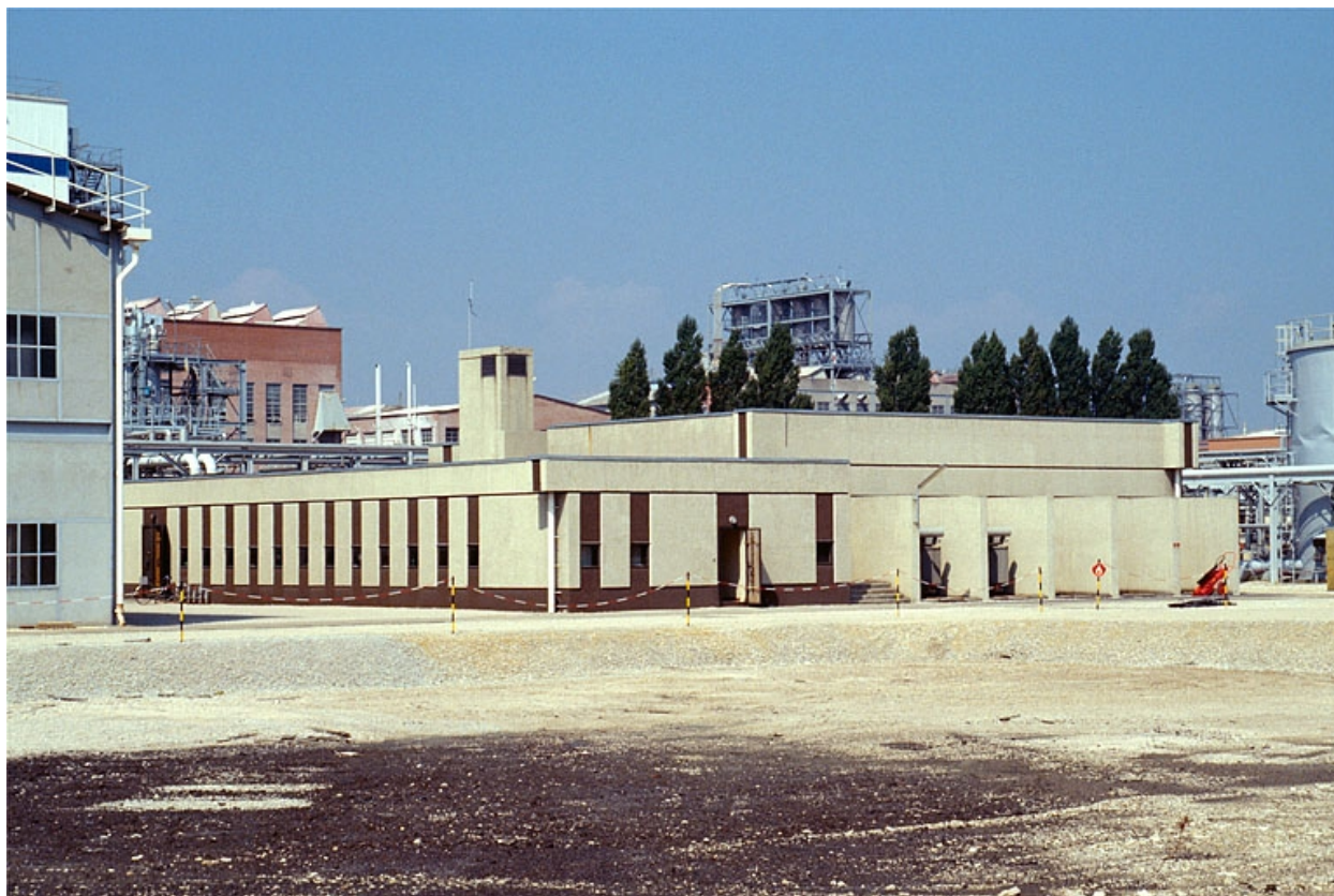
Salle de contrôle type blockaus du P79 (29).
