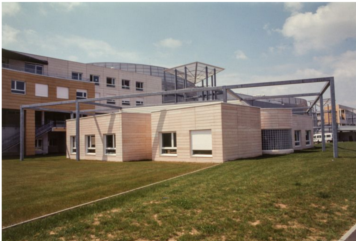
Bâtiment de l'administration.
