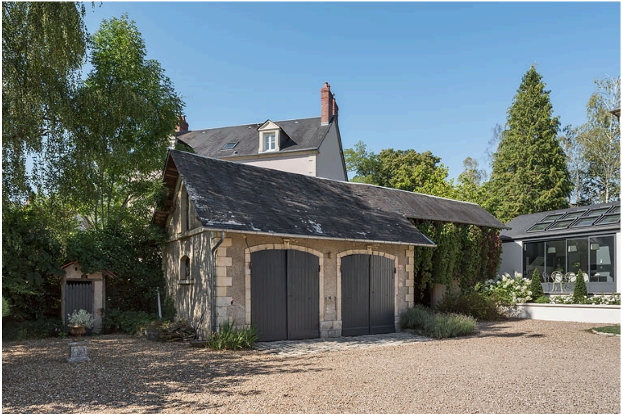
Dépendance (remise-écurie) côté sud.
