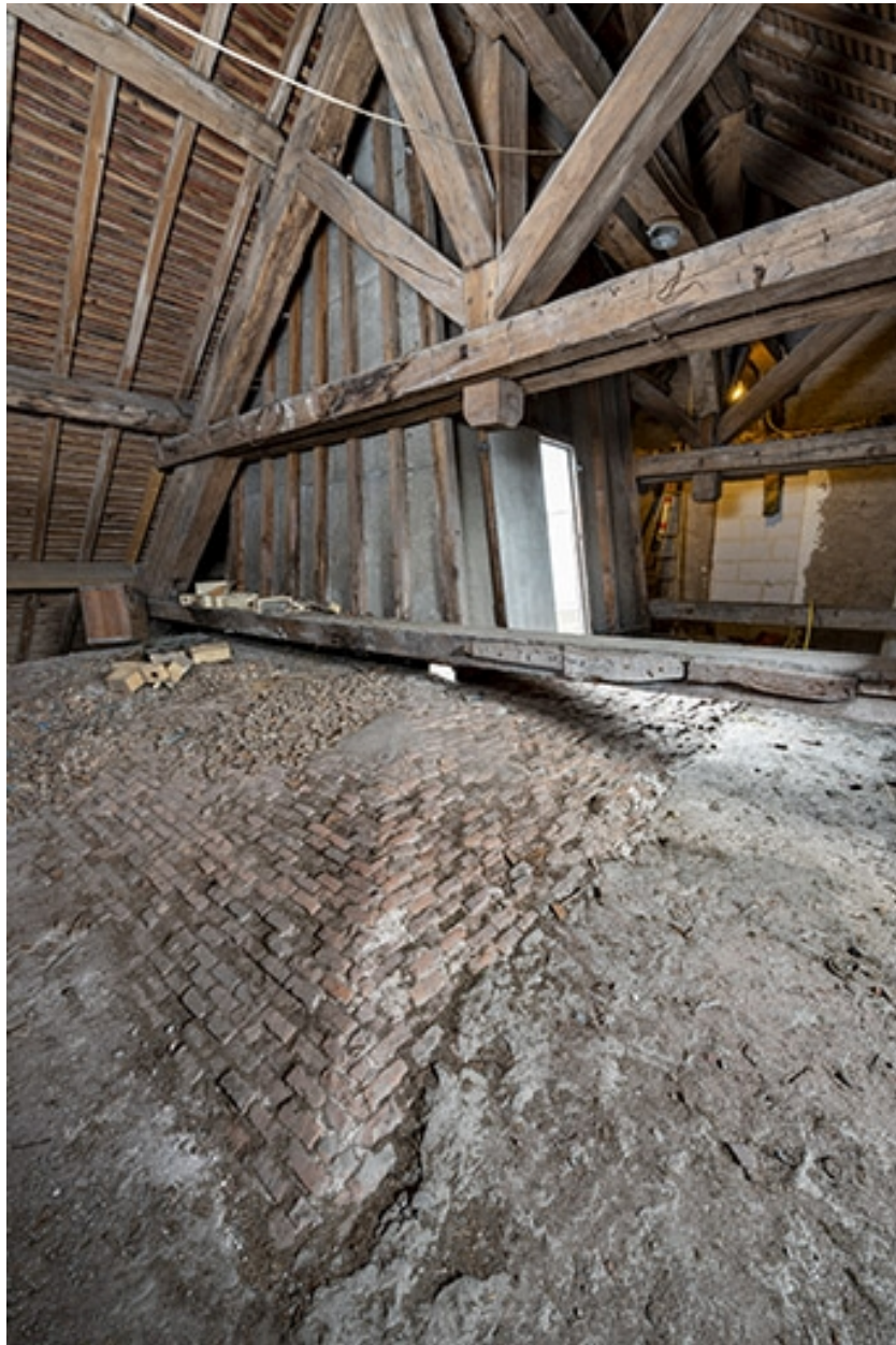
Voûte de l'ancien Bain des Capucins et charpente.
