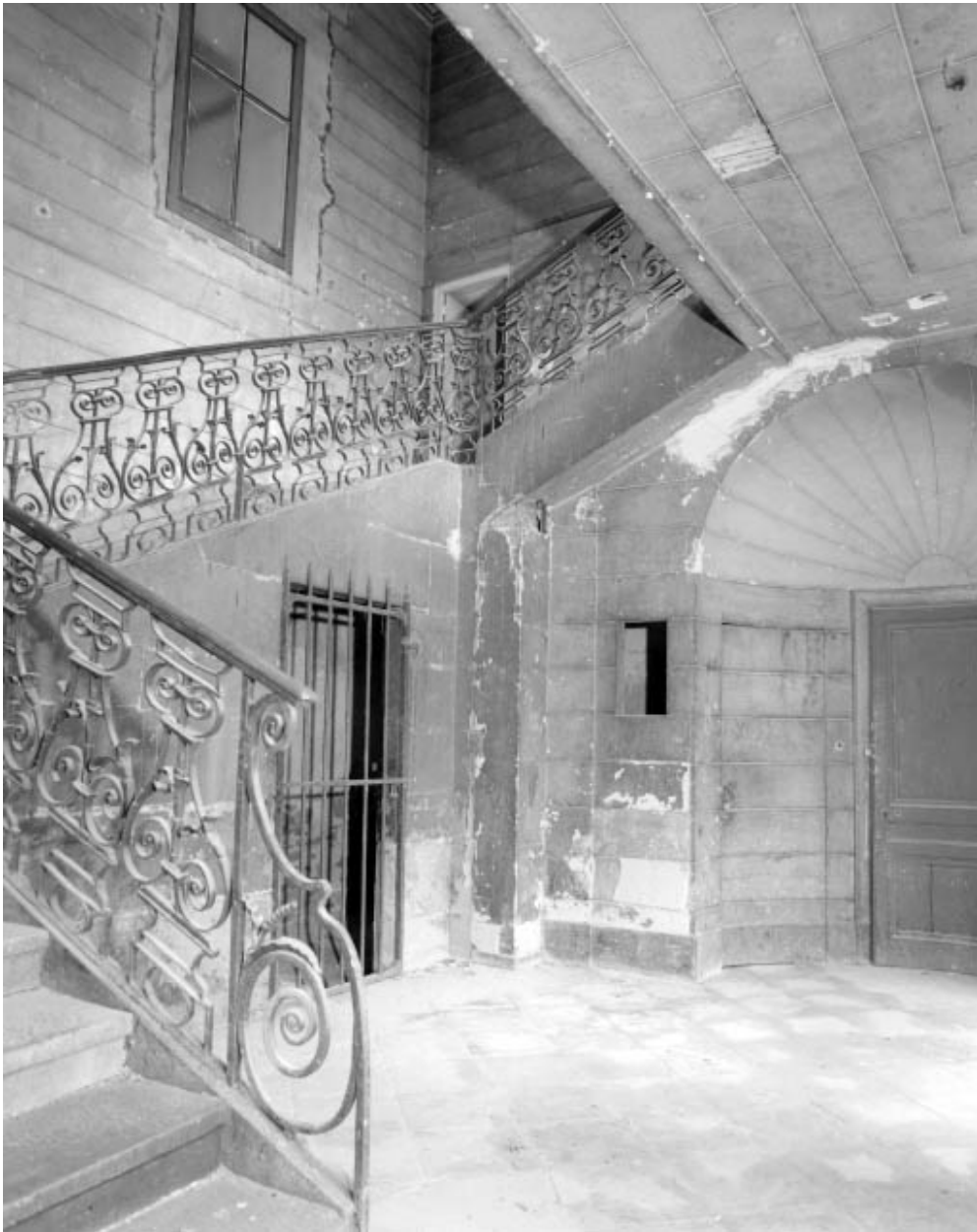
Intérieur : escalier d'honneur, vue d'ensemble en hauteur.
