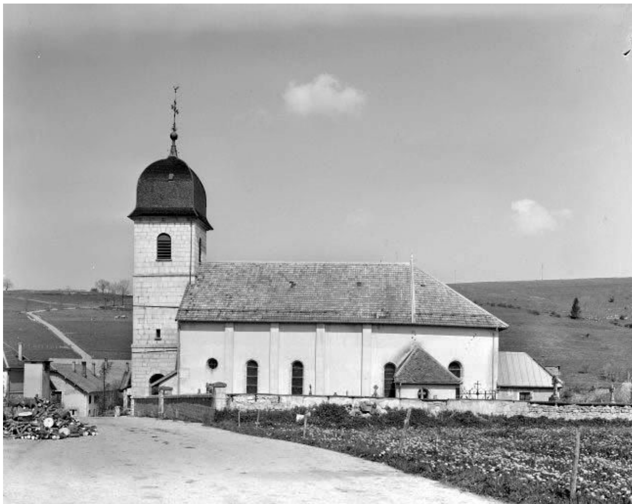
Extérieur : façade latérale droite.
