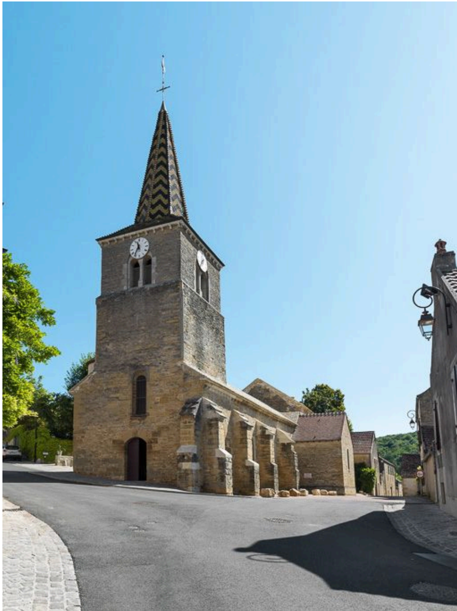
Vue d'ensemble, façade et élévation sud-ouest.
