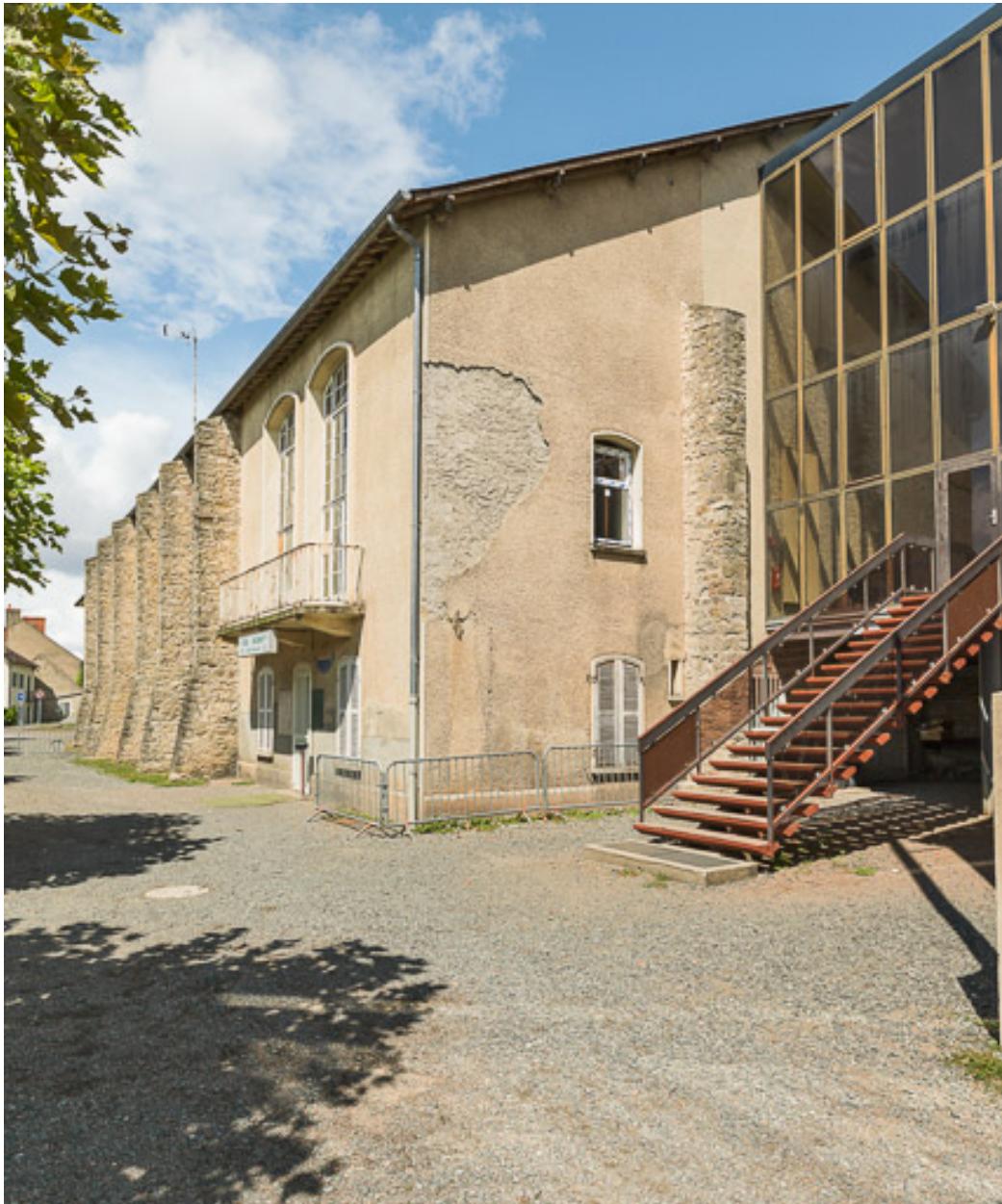
Vue du bâtiment et des contreforts.
