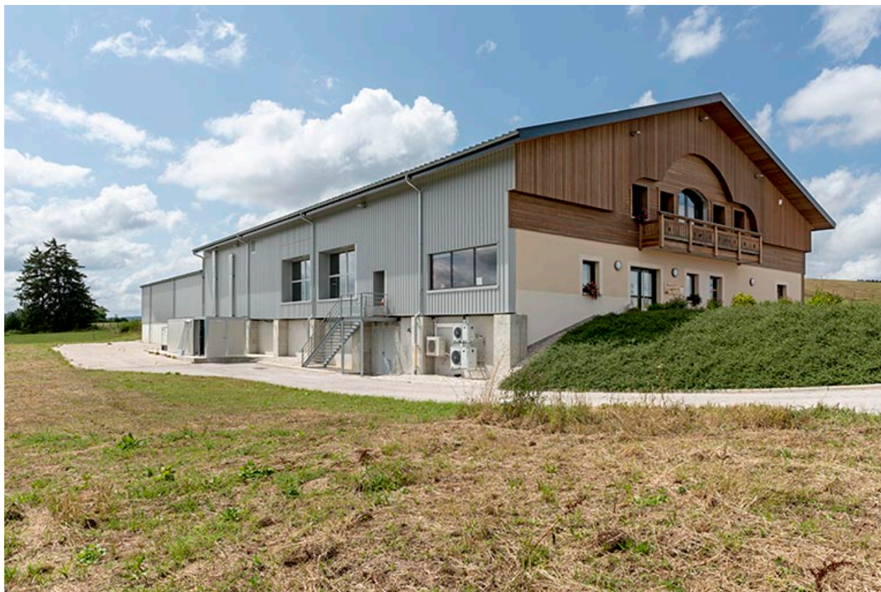
Façades antérieure et latérale gauche.
