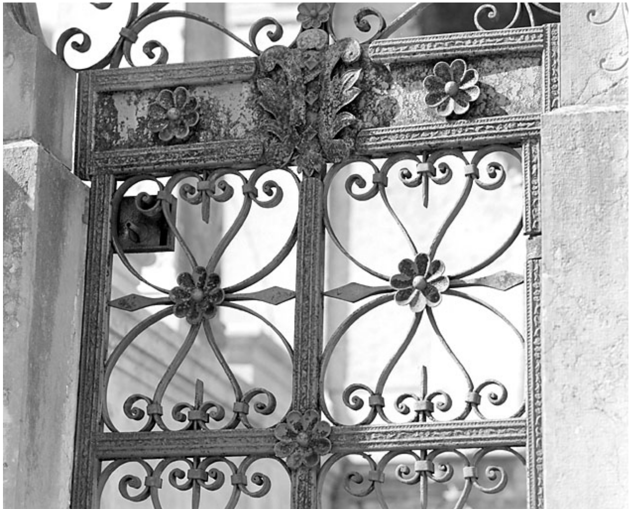
Grille : détail de la partie basse.
