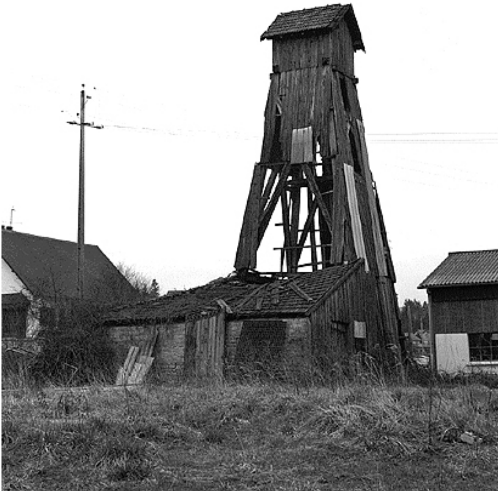
Chevalement du puits n° 10 en 1985.
