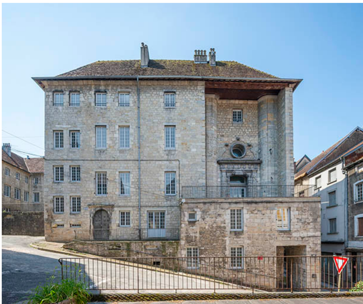
Façade nord du bâtiment sur rue.
