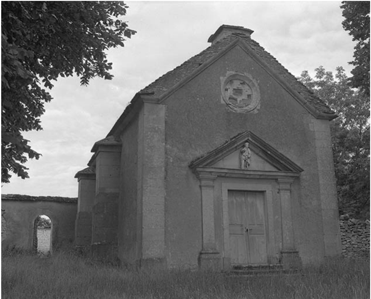
Façade de la chapelle avec rosace (murée) et porte à fronton décoré d'une statue. A gauche, façade latérale avec contreforts.
