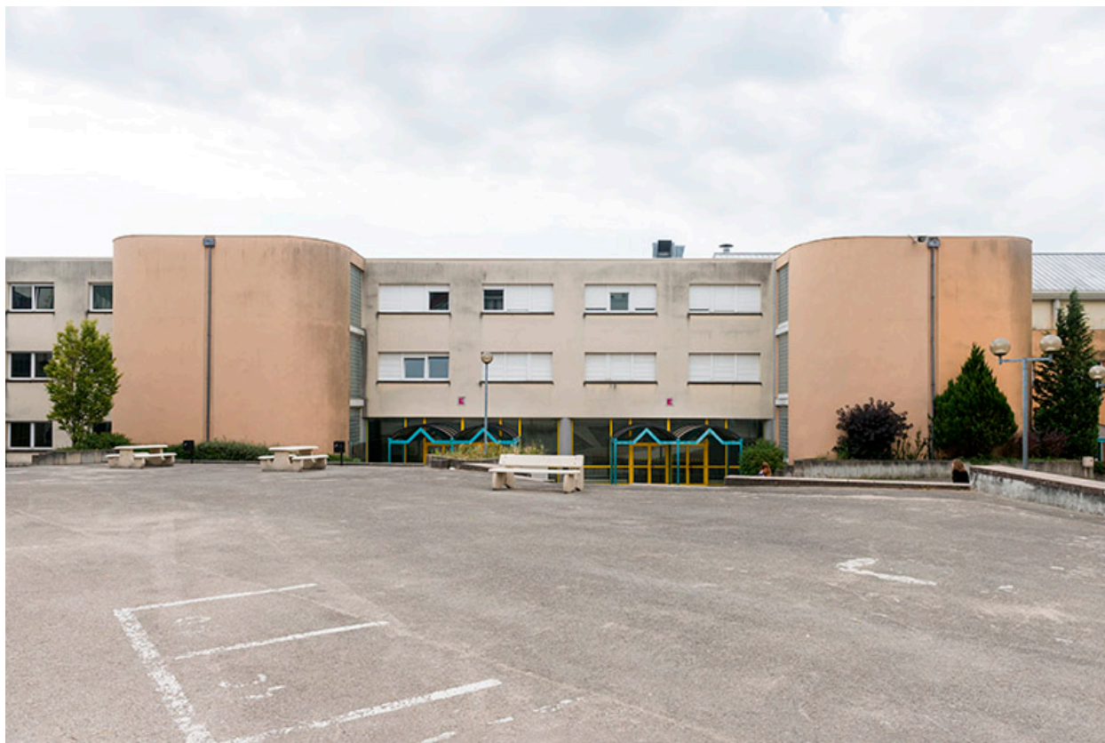
Façade nord sur cour du bâtiment de l'administration et des ateliers.
