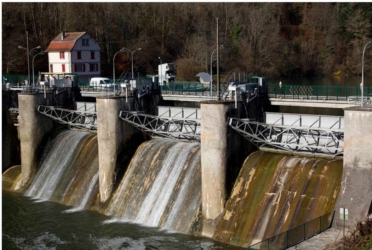
Barrage depuis la rive gauche en aval.
