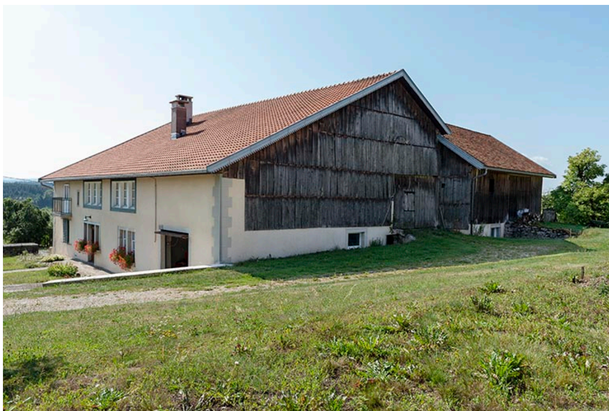
Façades antérieure et latérale droite.
