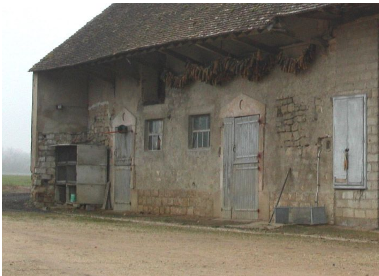
Vue d'ensemble de la façade.
