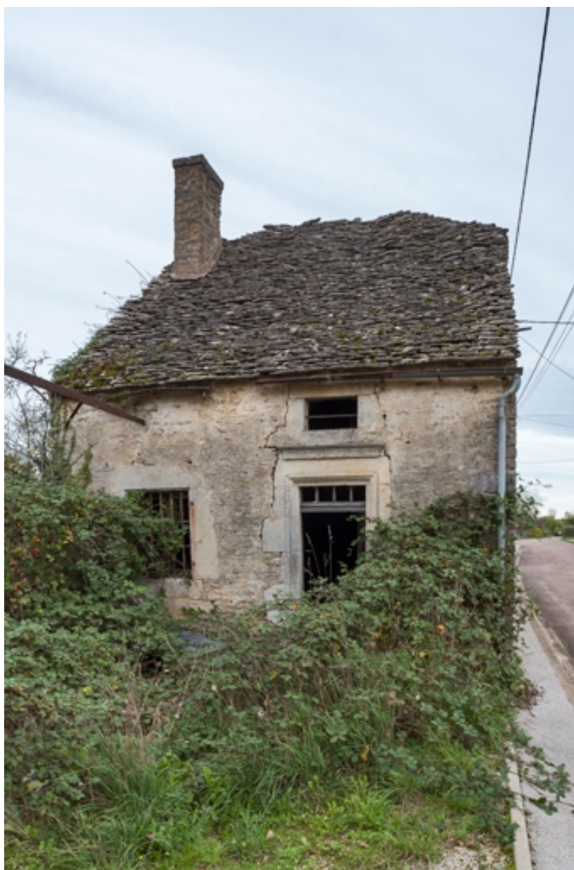
Vue de la façade ouest.
