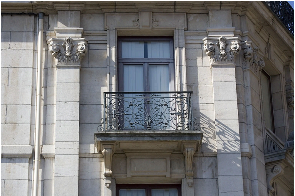
Détail d'un balcon ponctuel entre deux pilastres.
