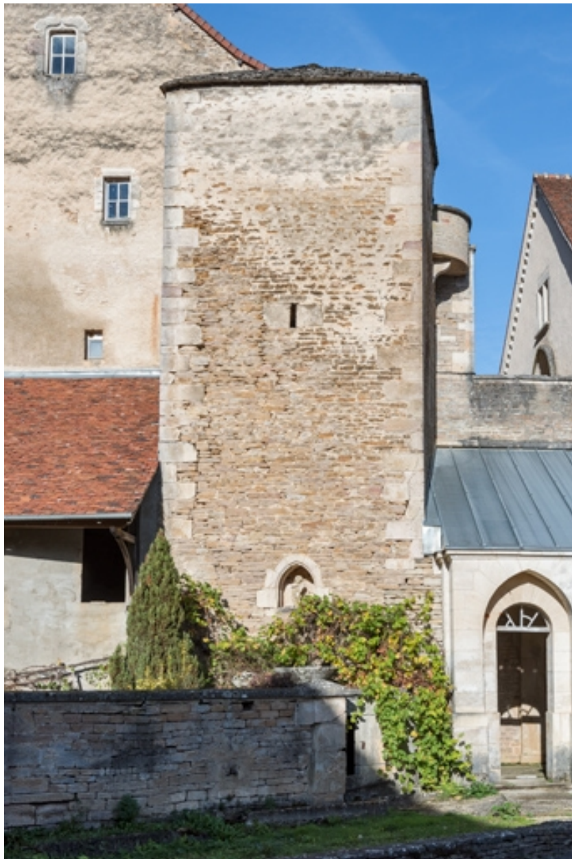
Vue de la façade nord-ouest.
