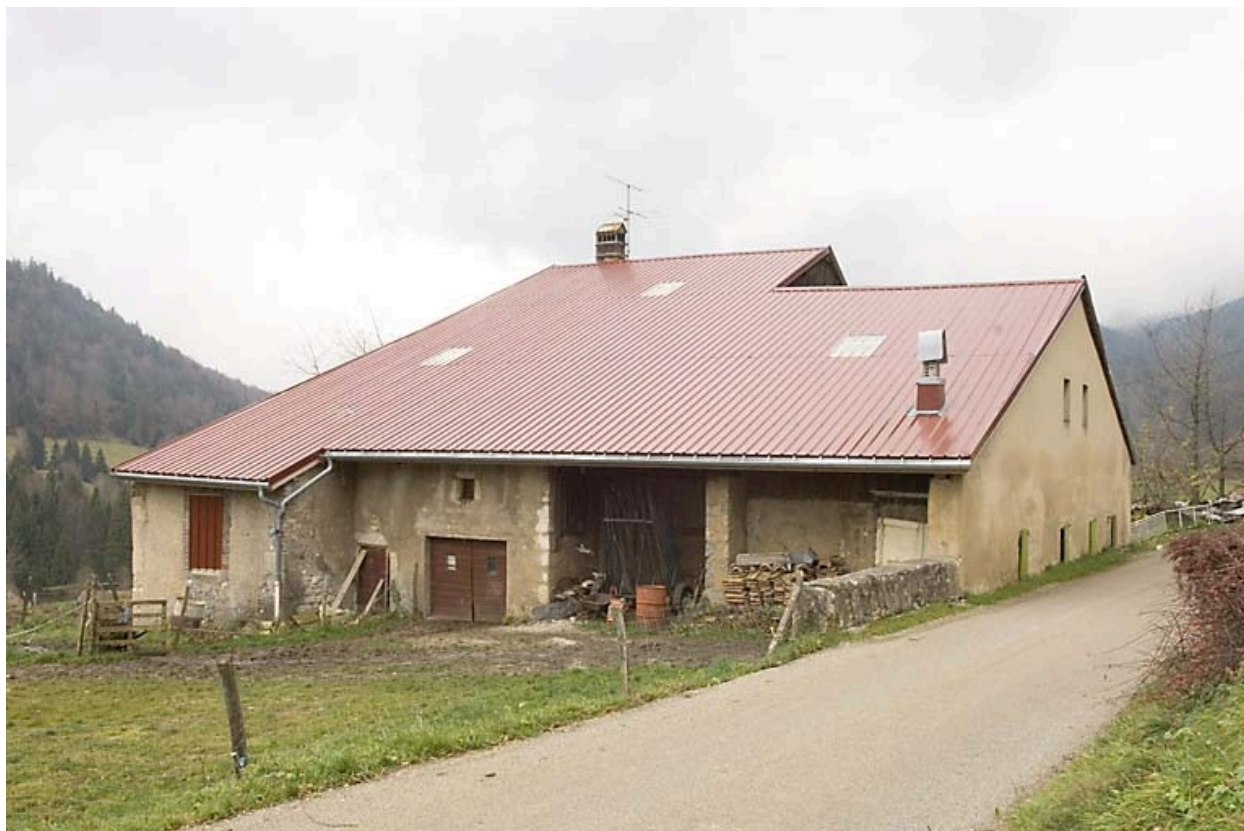
Façades nord et ouest.
