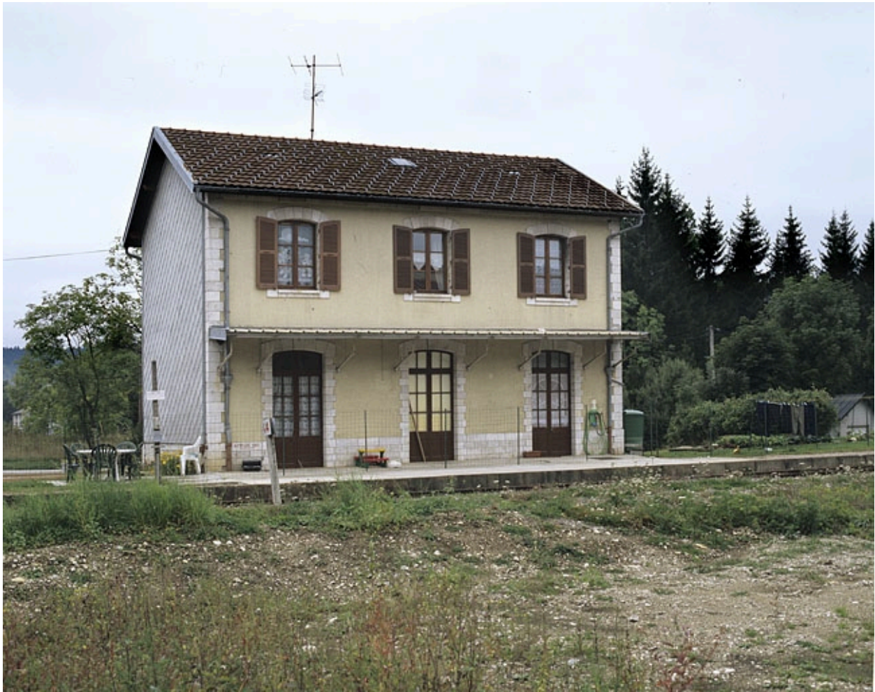
Bâtiment des voyageurs : élévation postérieure, de trois quarts gauche.
