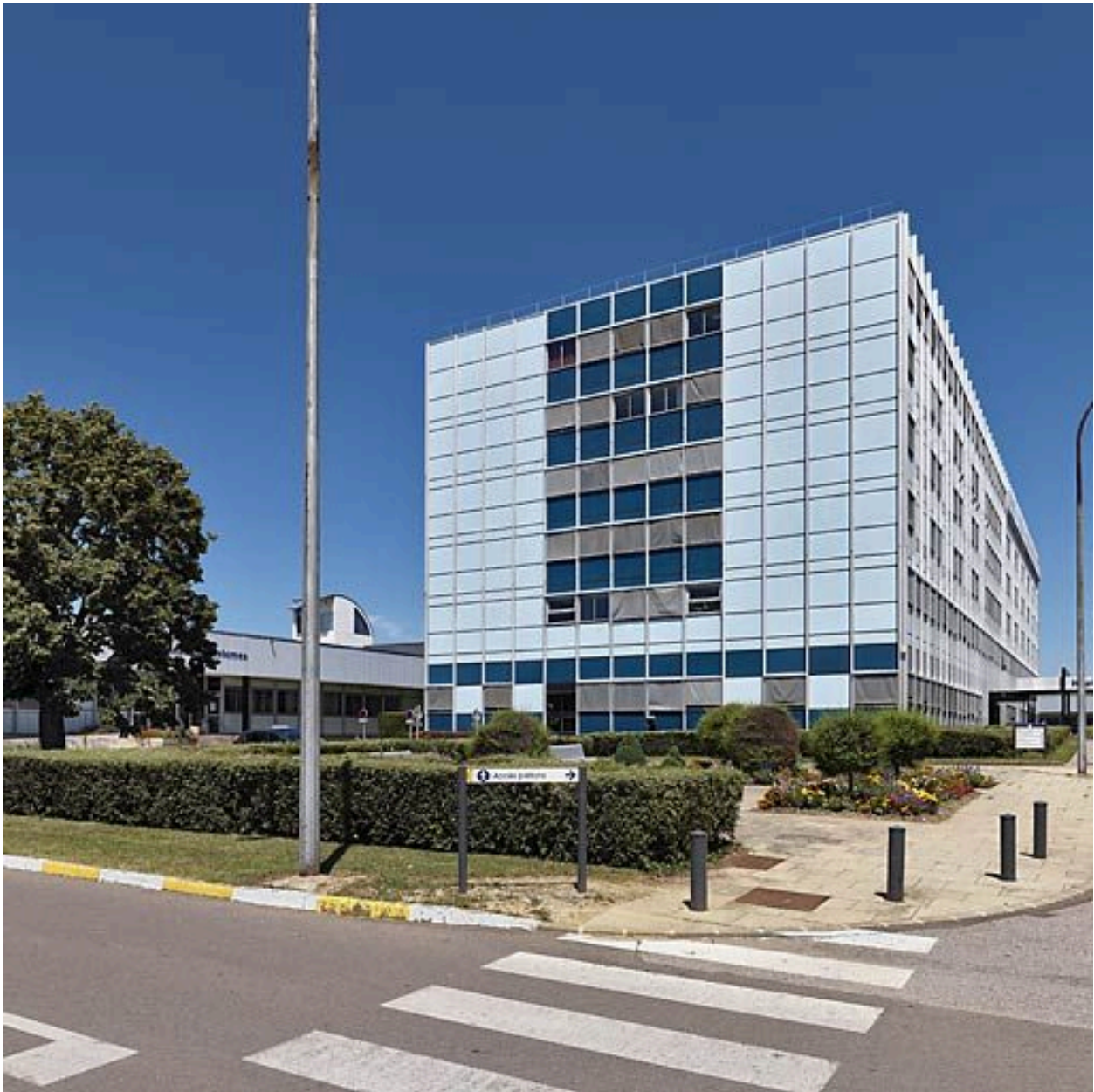
Bâtiment principal, vue d'ensemble de trois-quarts.
