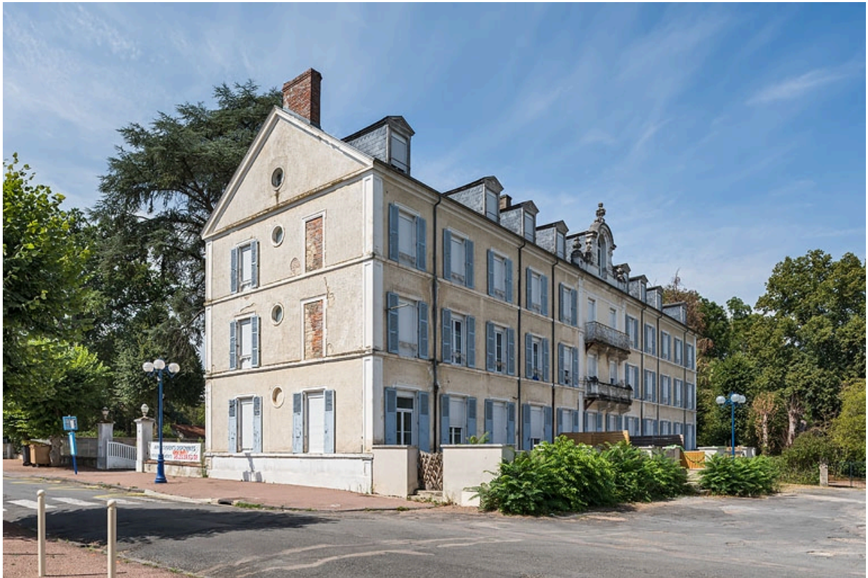
Façade nord du corps principal, vue en 2020.
