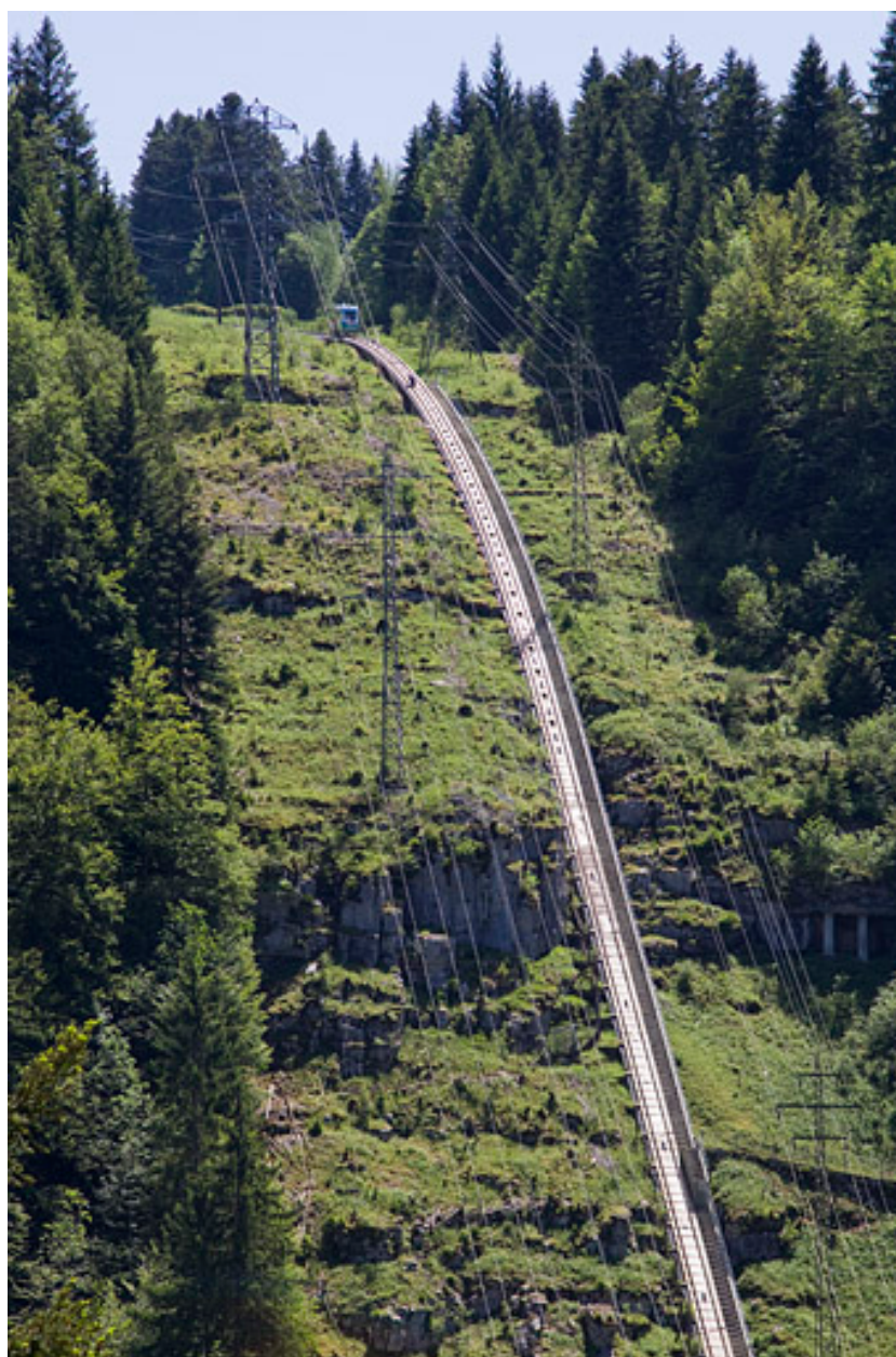
Centrale du Châtelot : vue rapprochée du funiculaire.
