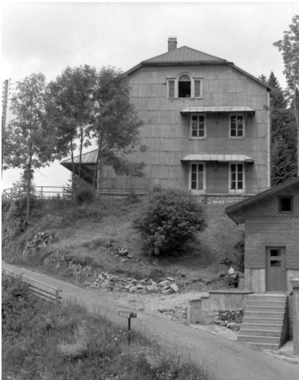
Face droite depuis le Chemin Départemental 25.
