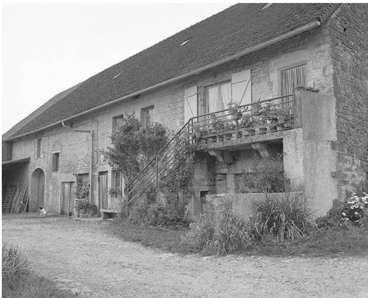
ferme cadastrée 1951 B3 186, située rue des Cornes Fayoles.
