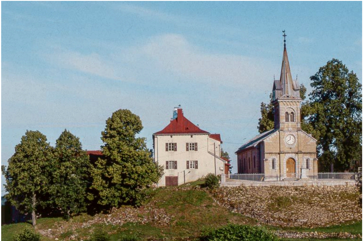
Vue éloignée du presbytère et de l'église.
