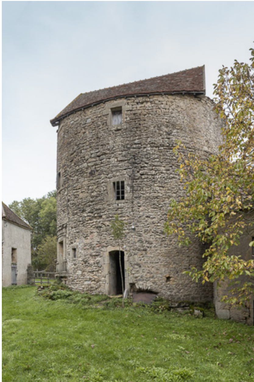
Vue de la tour de Chassagne au sud
