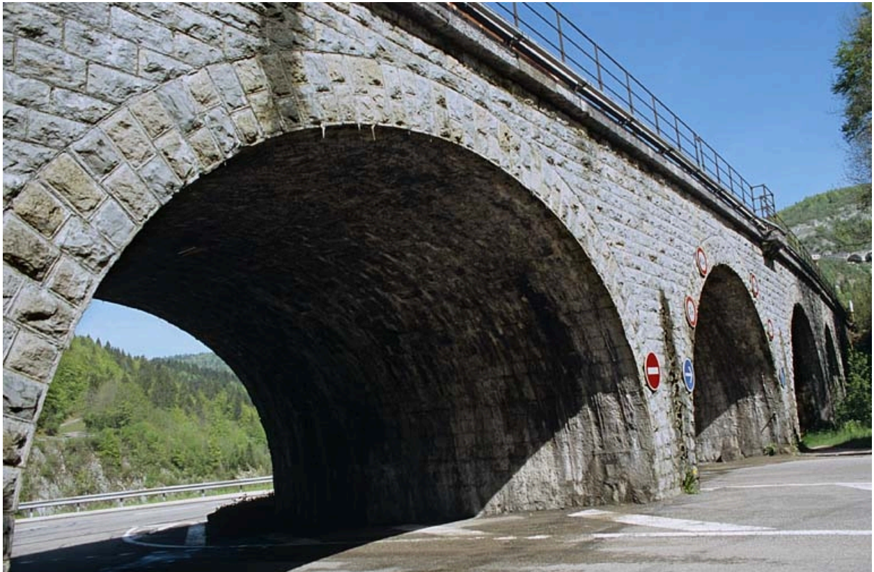
Elévation occidentale vue en enfilade, depuis le sud-est.
