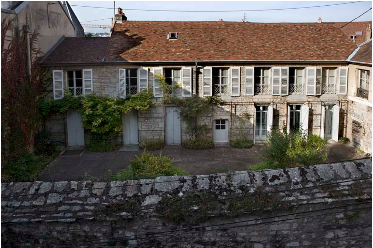
Vue d'ensemble de la façade postérieure depuis le jardin de l'hôtel Franchet de Rans.
