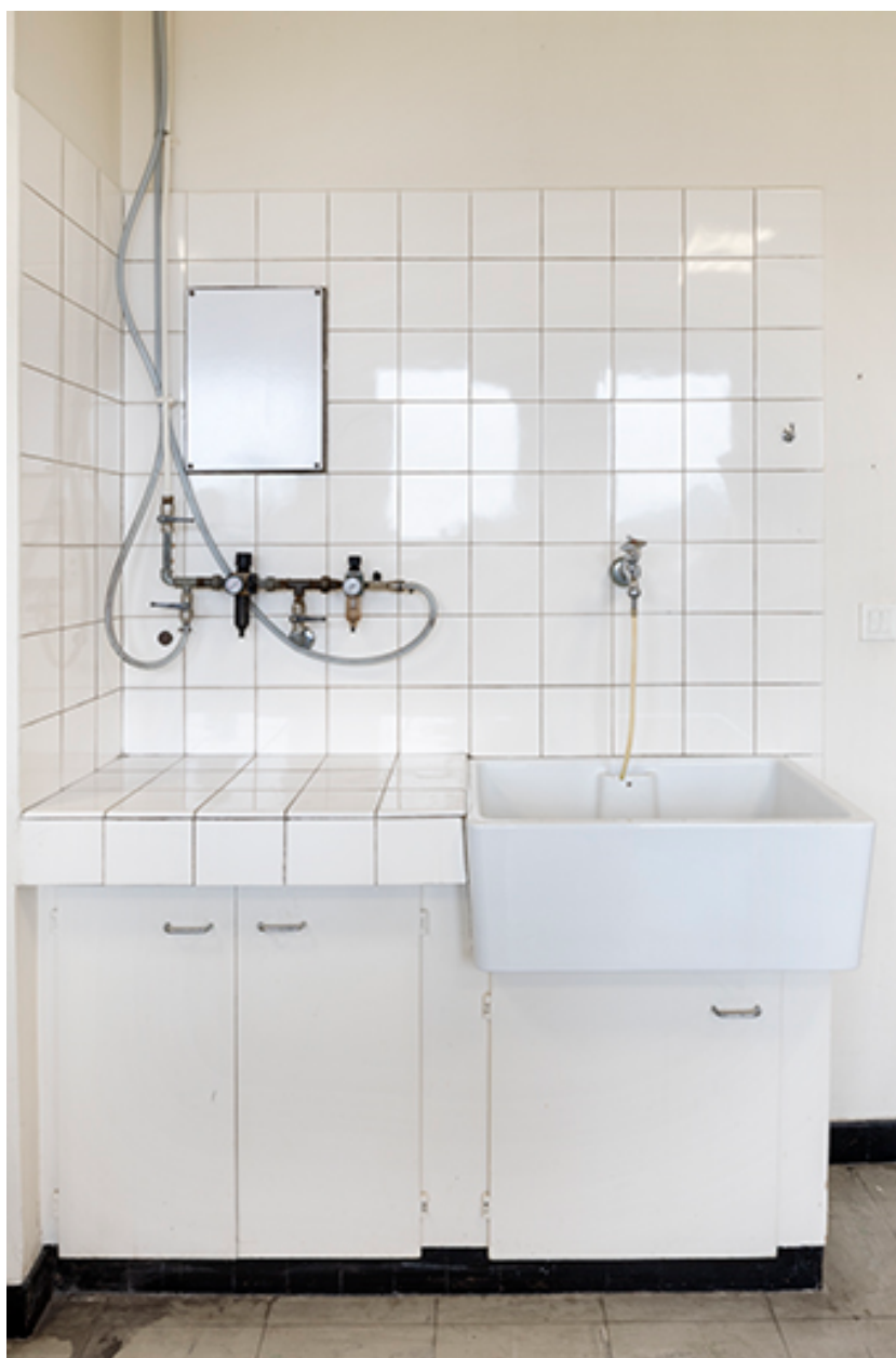
1er étage de soubassement, laboratoire de chimie et des essais mécaniques : paillasse
