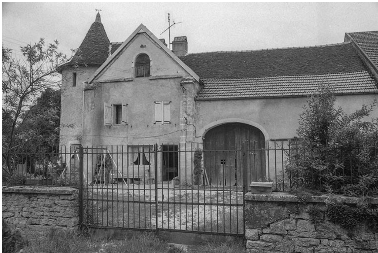
Façade antérieure depuis la cour.
