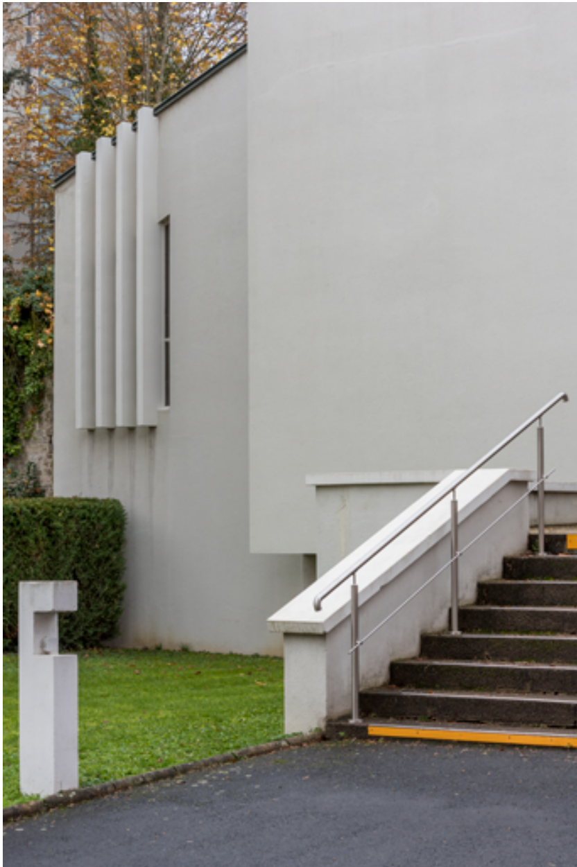
Détail de la façade est.
