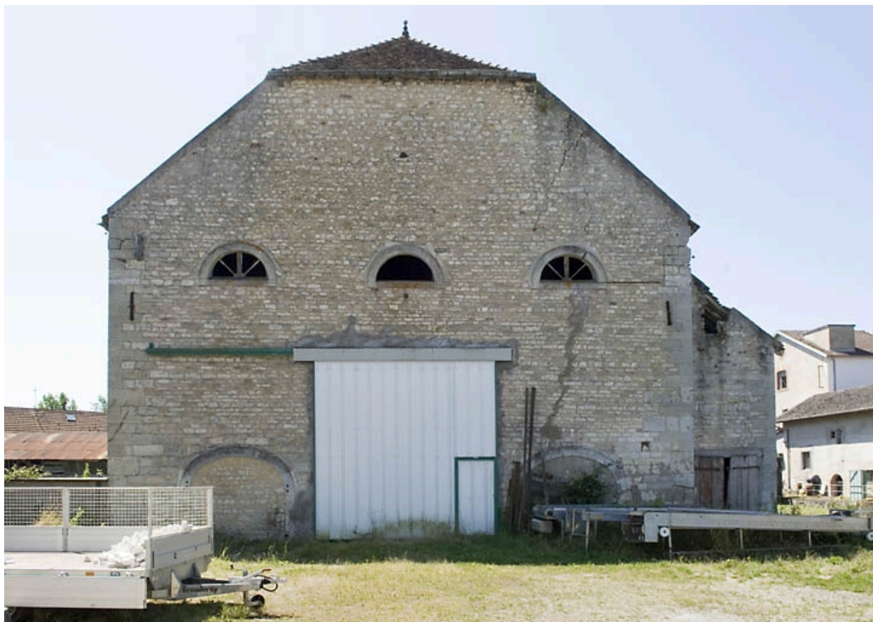
Mur-pignon nord du haut fourneau.
