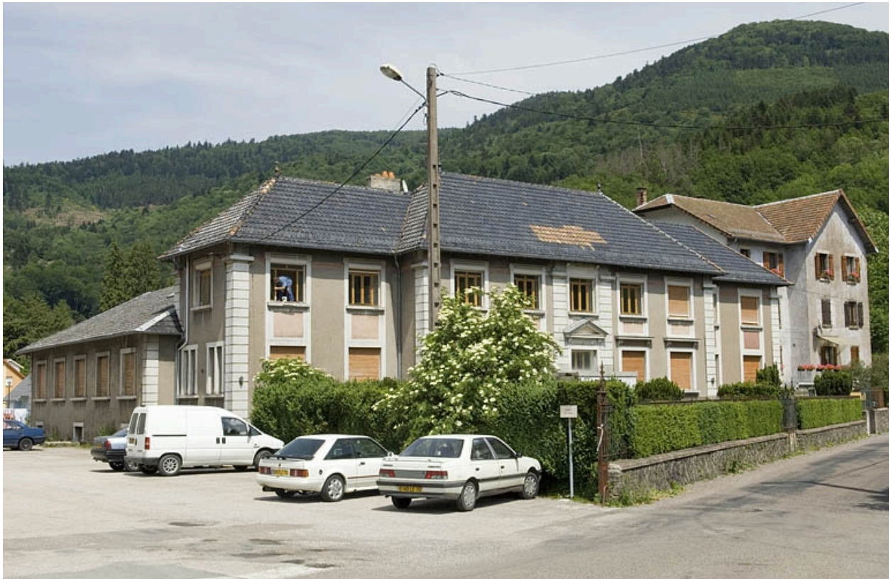
Immeuble de bureaux.
