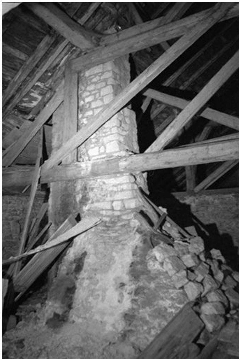
Intérieur : charpente et cheminée.
