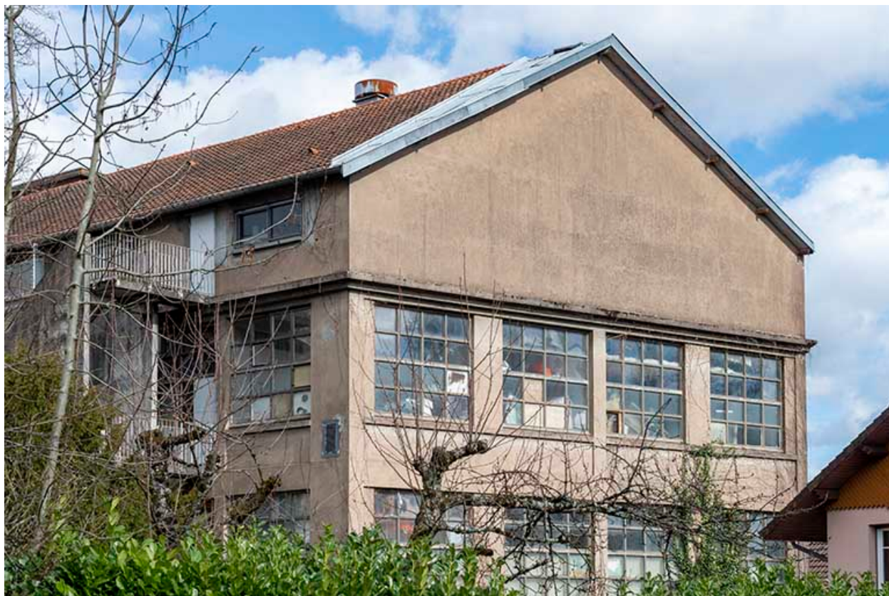
Pignon sud de l'entrepôt industriel.
