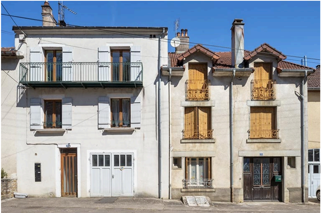
Rue Thiers, façades des maisons n° 31 et 33.
